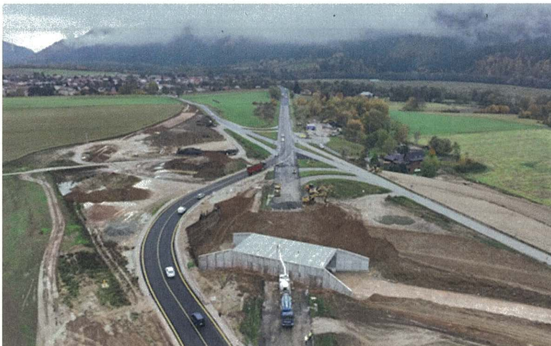
Cesta I/66 budovanie novej križovatky Predajná – nehodové miesto
